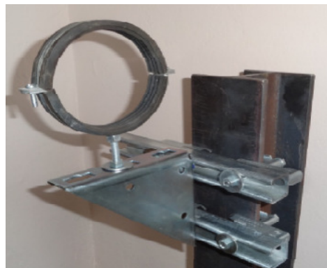
Montaje de una consola de apoyo
