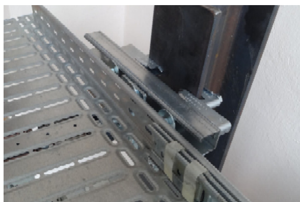
Sujeción rápida de una bandeja de cables
