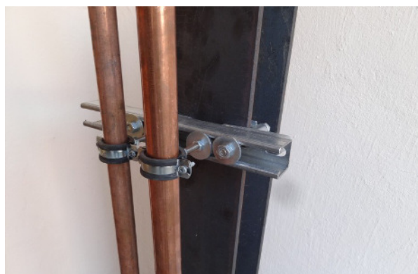
Guía de tubos en la viga de acero sin complicaciones
