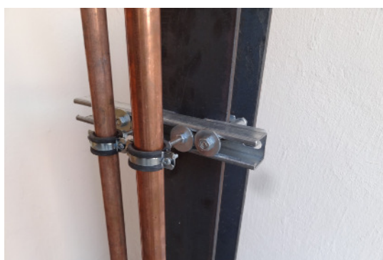
Guida dei tubi su un longherone d'acciaio eseguita con la massima semplicità
