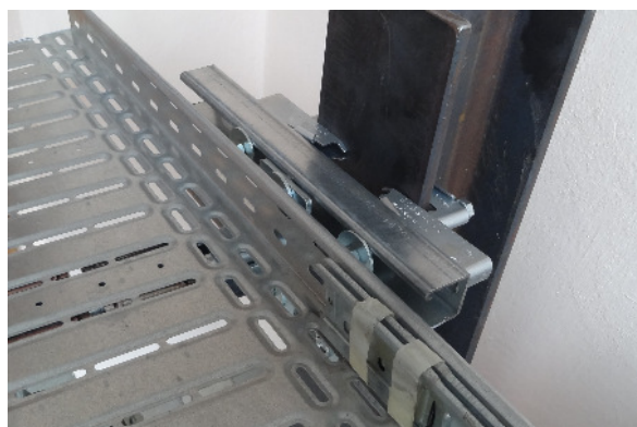
Rapido fissaggio di un canale per cavi
